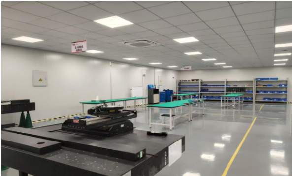
无尘车间 Dust-free workshop
